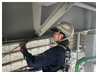
作業風景 配線作業
