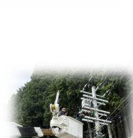
PASの取替を行っています
