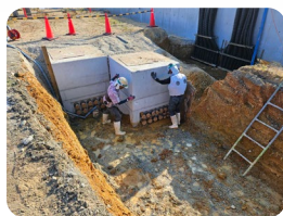
ハンドホール設置作業
