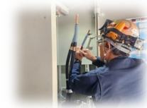
高圧ケーブル端末処理状況
