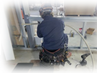
隠ぺい配管,BOX仕込み状況
